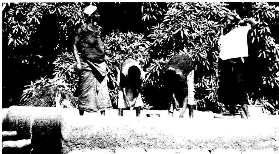
Photo 12. Traitement de la toiture-terrasse (toit plat en terre).
