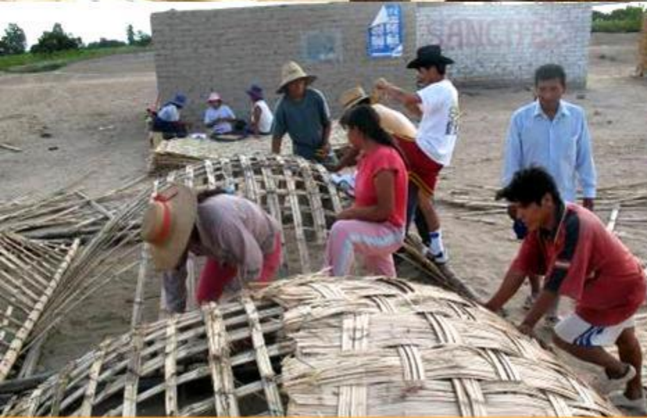
Forrado del techo con esteras para sostener el barro.
