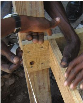
**Étape 4:** clouer les poteaux et les montants à la sablière en utilisant des clous de 5 pouces (2 clous de 5 pouces pour chaque montant).
