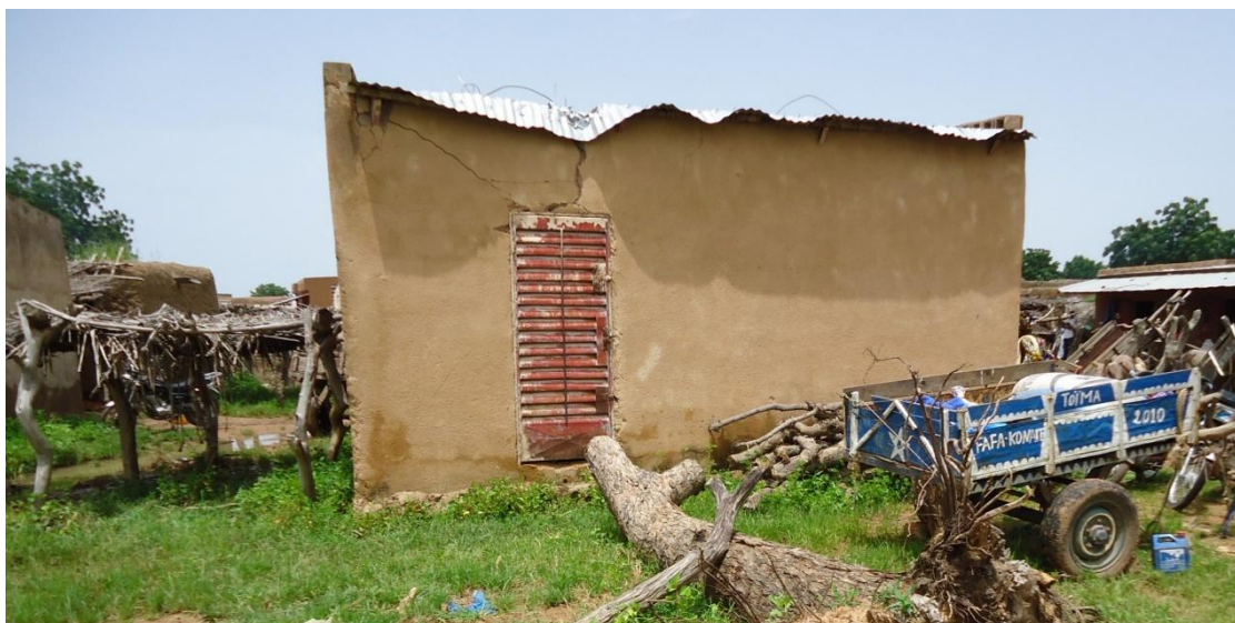
Habitation actuelle (semi-moderne cf. Figure 4) avec toit en tôle ondulée, village de Toubacoro, région de Koulikouro. Source : ACTED, août 2012
