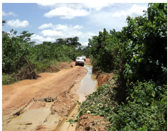
la route est rétrécie à cause des creux
