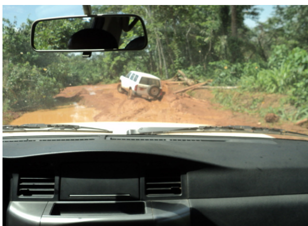
C'est avec difficulté que la voiture de la mission a pu traverser cette partie de la route
