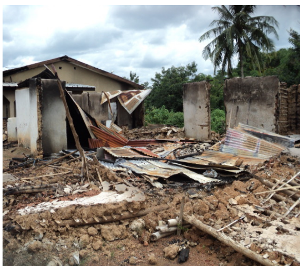
Destruction d'une maison en banco avec toiture en tôle
