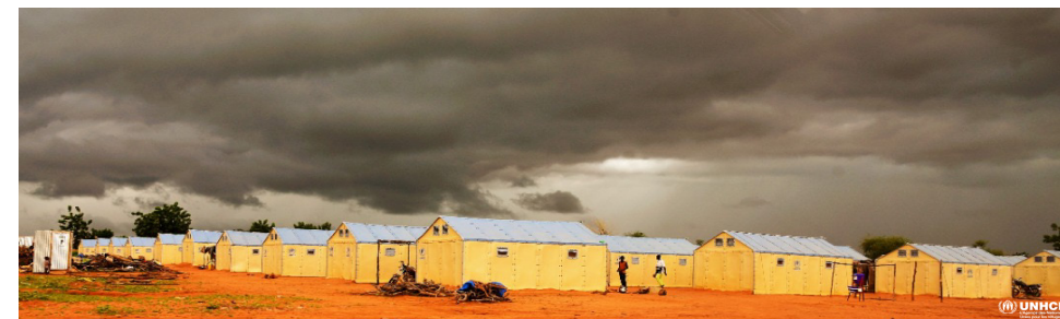
Nouvelle Installation au Site du Marché à Kongoussi
