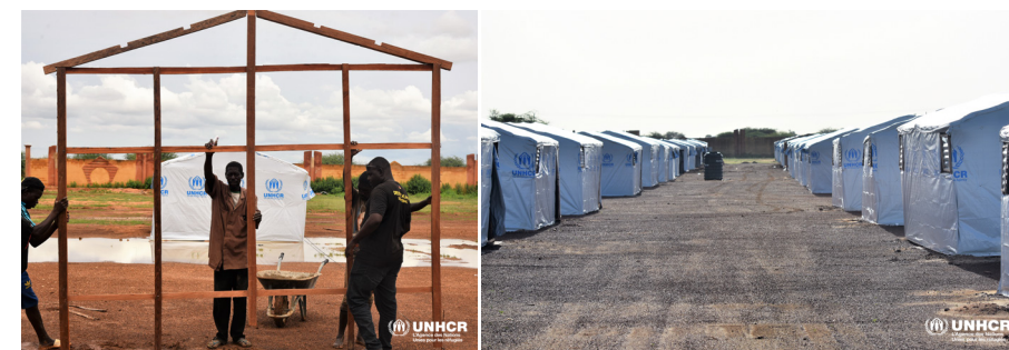
Construction des abris au site du Stade de Dori
