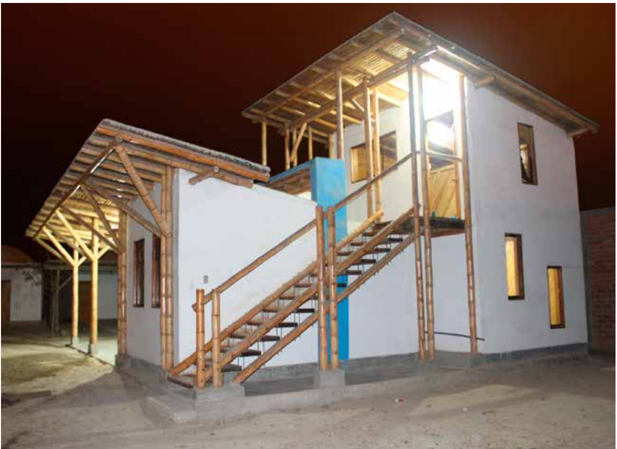
Edificación terminada con sus acabados e instalaciones
