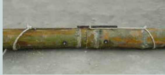
Dos cañas unidas con sogas de presión y colocación de dos pernos.
