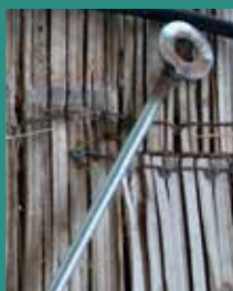
Alternativa al gancho: soldar una arandela
