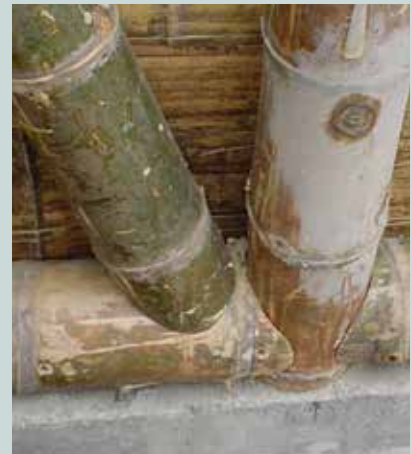
Aplicación de boca de pescado y pico de flauta
