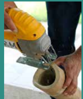
4 Corte boca de pescado con caladora
