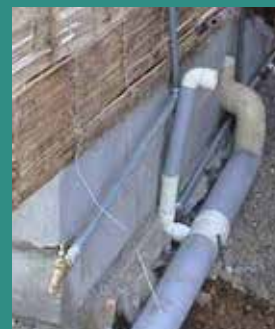
4 Conexión entre tuberías de 2" y 4"
