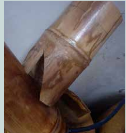
Aplicación de un pico de flauta con “oreja”.
