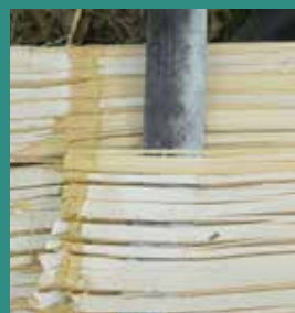
2 Limpieza de los nudos interiores
