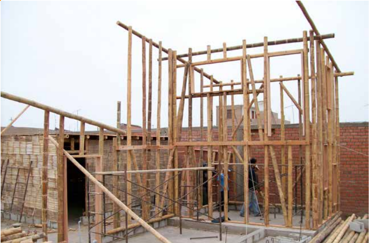
Construcción del esqueleto de bambú sobre los cimientos
