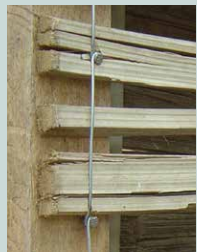
Clavado definitivo después de colocar el alambre
