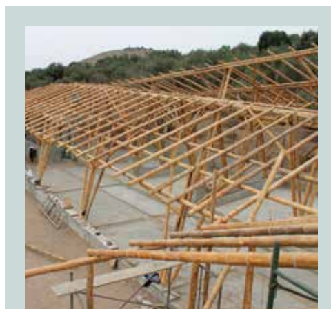
Colocación de la correas
