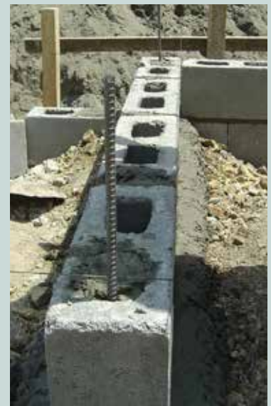
Fierro de construcción para conectar una columna
