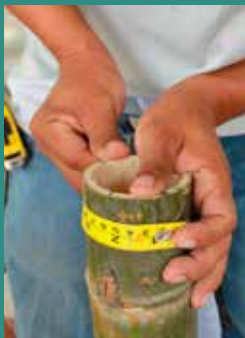
1 Trazado con wincha
