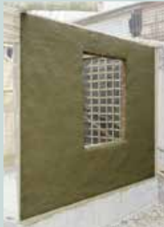
Recubrimiento tipo quincha
