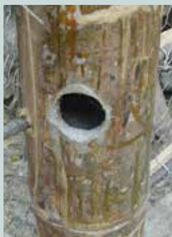
Relleno de mortero
