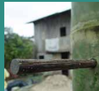
Taco de madera como anclaje
