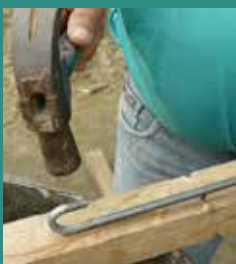
Formar un gancho. Calentar la varilla para facilitar el proceso
